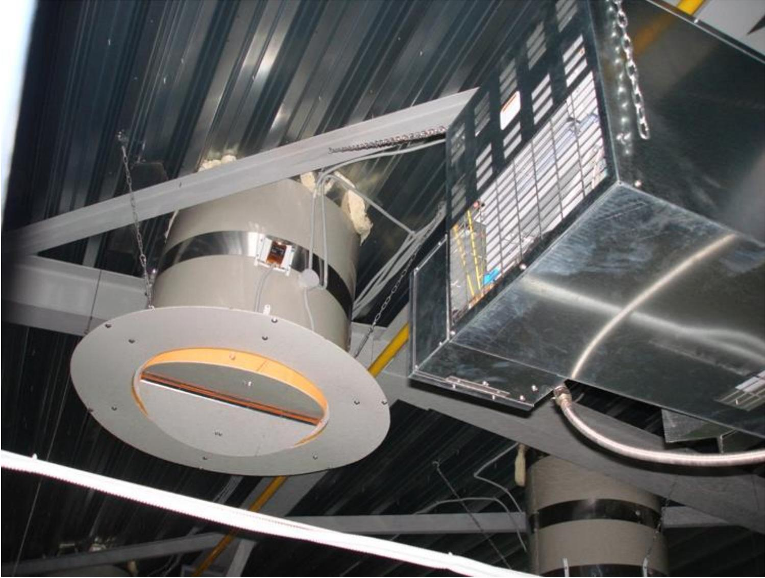
При повышении температуры воздухообмен плавно возрастает для отвода лишнего тепла от животных. При снижении температуры ниже заданного значения воздухообмен уменьшается до заданного минимального уровня и включаются устройства обогрева.
