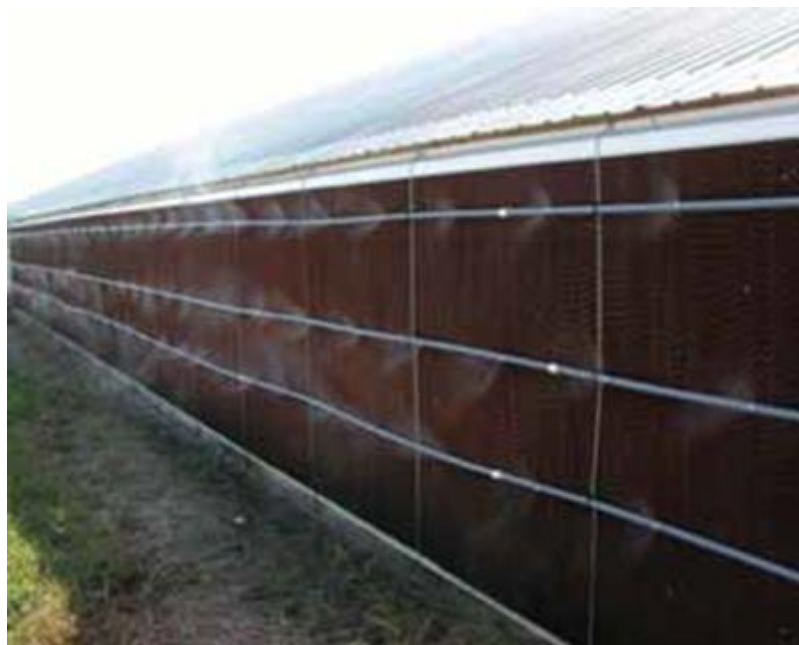
Рис. 5. Наружная система туманораспыления, призванная понизить температуру входящего воздуха за счет испарения оборудование
