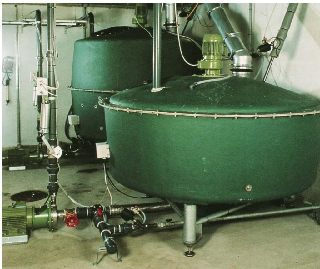
**Рис.** Смеситель для приготовления влажных кормосмесей ACO funke
