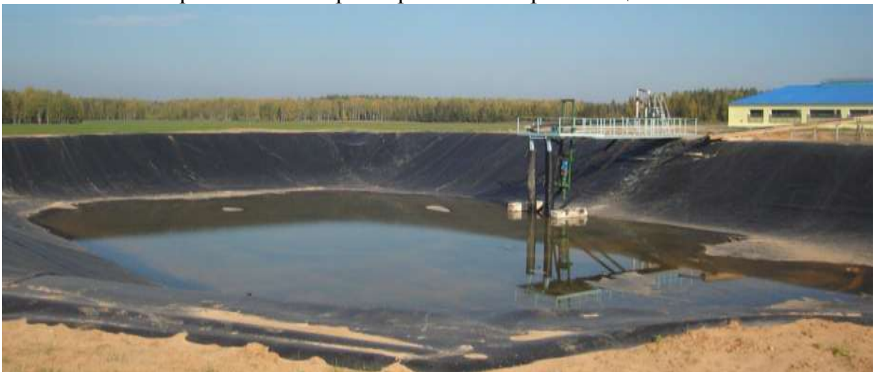
Рис. 25 Пример пленочного навозохранилища. Общий вид.
